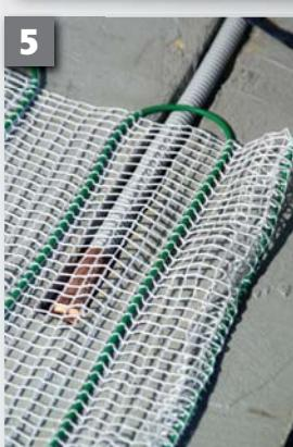
Detail umístění čidla pod rohoží v podlaze
