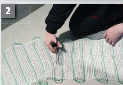
Naformátujeme rohož do půdorysu. Pozor! Nesmíme poškodit topný kabel!
