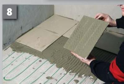
Natahujeme flexibilní lepidlo a pokládáme dlažbu. Pozor na poškození kabelu! Ihned po dokončení pokládky opakujeme měření viz 7.
